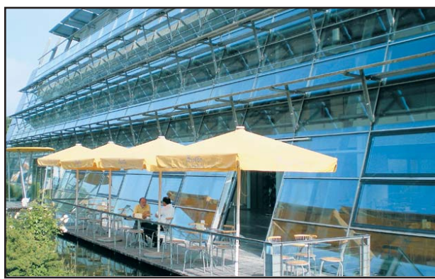
La Solar-Fabrik, numéro 1 du photovoltaïque allemand. PFY
