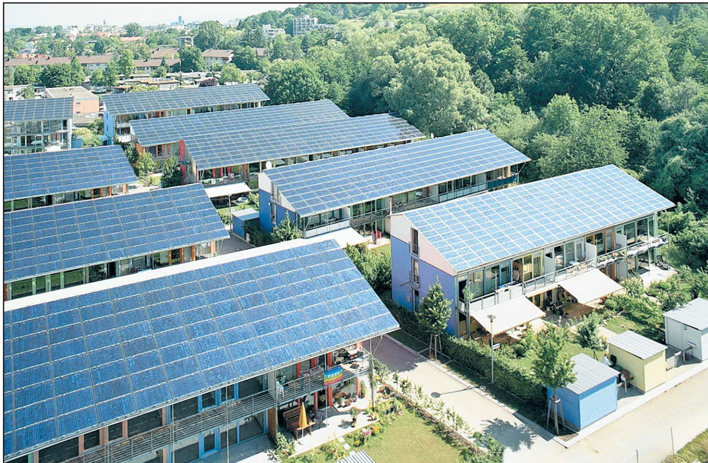
Le lotissement solaire du quartier Vauban: des maisons qui produisent davantage d'énergie qu'elles n'en consomment. WWW.SOLARSIEDLUNG.DE
